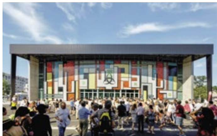
La salle des fêtes du Grand-Parc a été entièrement rénovée tout en gardant sa façade familière au sein du quartier.
