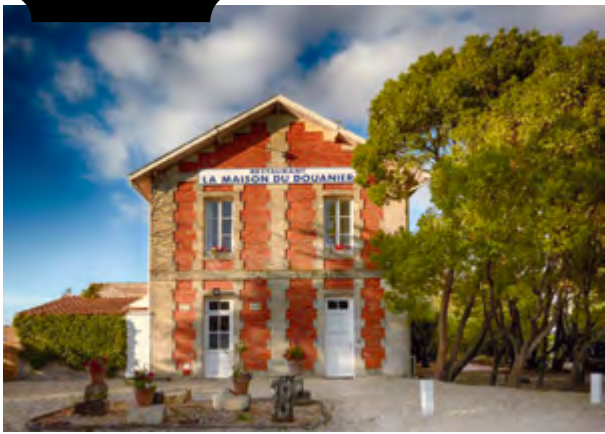
© La Maison du Douanier
