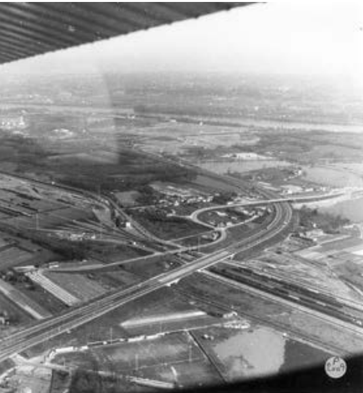
La rocade en 1976, au niveau des échangeurs 19 et 20 (secteur sud).
