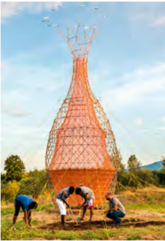
Le Warka Water, piège à humidité expérimenté dans les zones de sécheresse.
